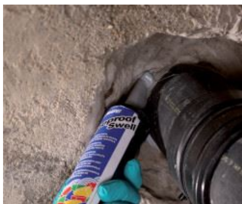
Gennemføring, forsejlet med Mapeproof Swell
