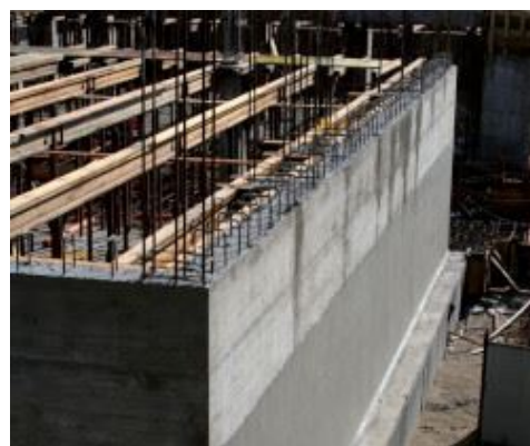
Støttemur, tætnet med Mapelastic Foundation efter støbning
