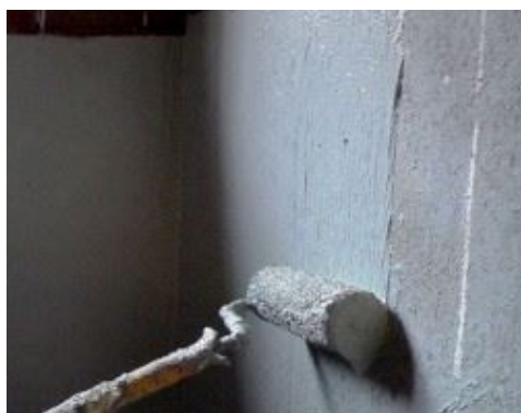
Påføring af Mapelastic Foundation med rulle på underlag, afrettet med Planitop HDM Maxi
