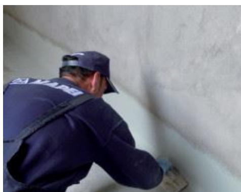
Mapelastic Foundation påført med spartel, for at tætne mod vand med negativt tryk
